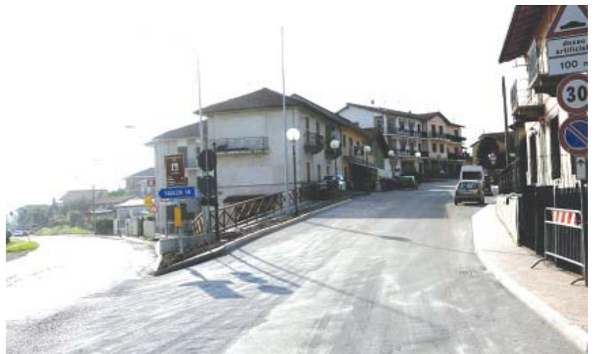
Scorcio di Via Paesana dopo i lavori (foto Battisti - Sanfront)
